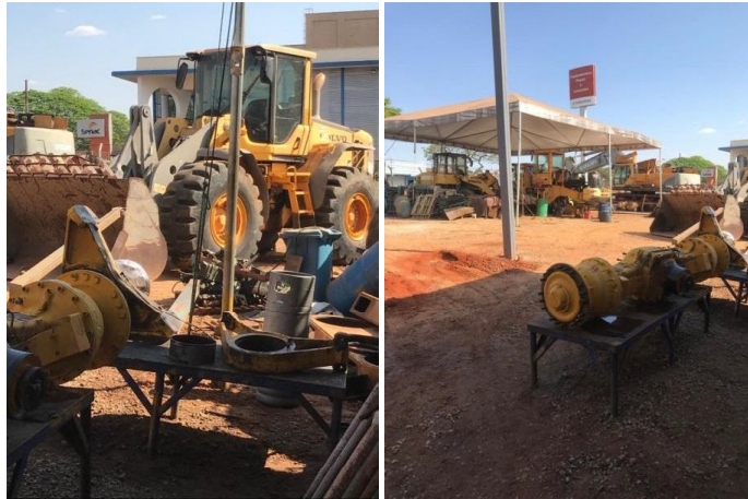
Máquinas em manutenção - Pátio Matriz - Av. Caiapó, 1073 - Santa Geneveva, Goiânia - GO.
